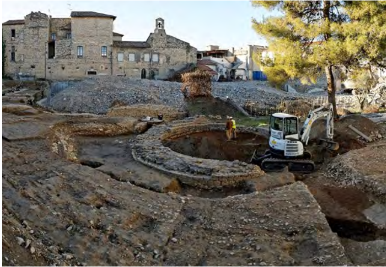
Jardin archéologique du musée de la Romanité pendant les travaux, 2017 © Ville de Nîmes
