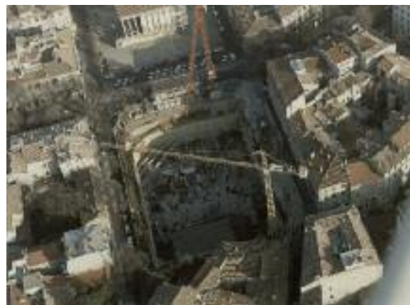
Vue aérienne des fondations en 1989 (@photo-aerienne- france.fr)
