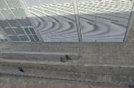
Façade latérale et rampes d'accès
