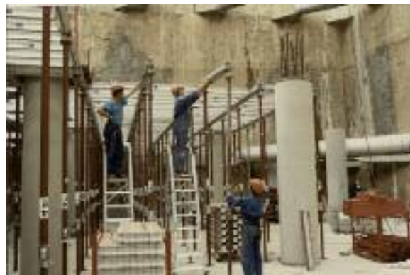
Sur le chantier en octobre 1989 (Cl. P. Blot)
