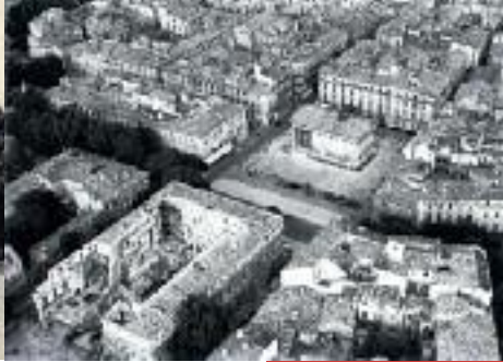
Le théâtre après l'incendie avant le déblaiement des ruines (Coll. Musée archéologique)
